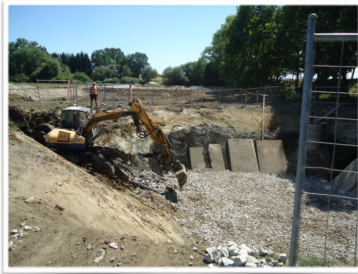
Probíhající stavba ČOV a kanalizace Malovice a Malovičky
